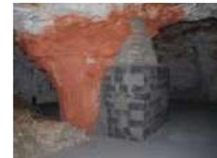
Confortement d'un pilier par maçonnerie (Lille) © INERIS
